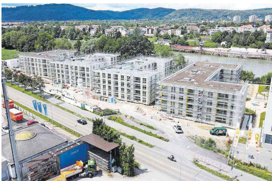
Die Rohbauarbeiten an den vier Gebäuden der zweiten Etappe des Salmenparks in Rheinfelden sind abgeschlossen.
