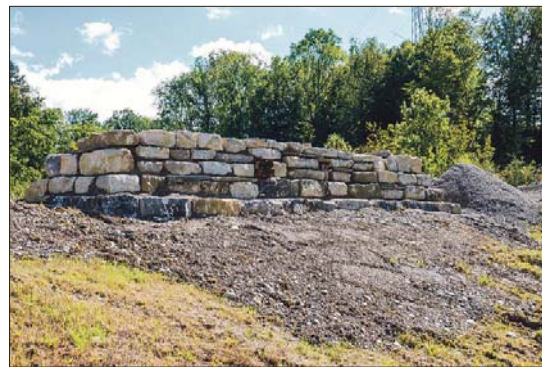
Die neue Trockenmauer
