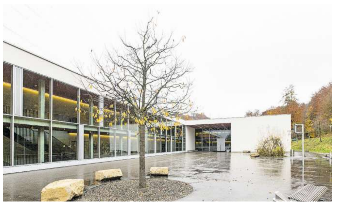
Die HPS Fricktal bezieht das ehemalige Oberstufenzentrum im August.
